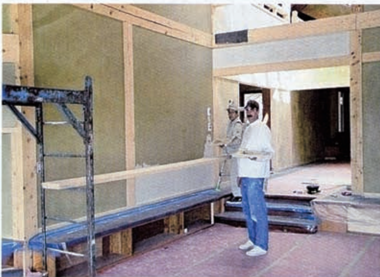
米国で受注した個人住宅の壁塗り作業。現地の職人に技術指導も行った。2006年、米コネチカット州
