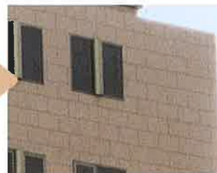
施工後 ●目地：Bタイプ ●材質：カラーrst-51
