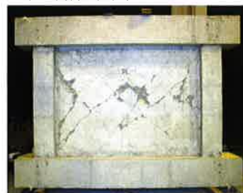
RC面(裏面) ひび割れを起こした壁面
