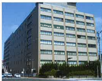
推定震度 5弱 ■オフィスビル 地震による外壁の被害は確認されなかった。
