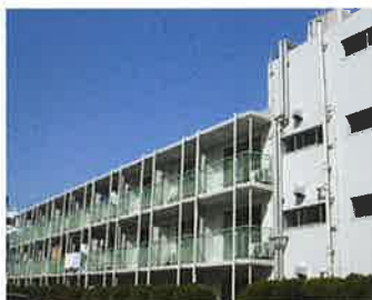
推定震度 5弱 ■独身寮 備え付けの自動販売機が倒れた。地震による外壁の被害は確認されなかった。
