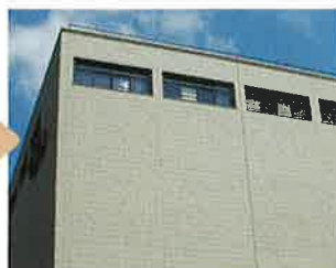
施工後 ●目地：Bタイプ ●材質：カラーrst-42
