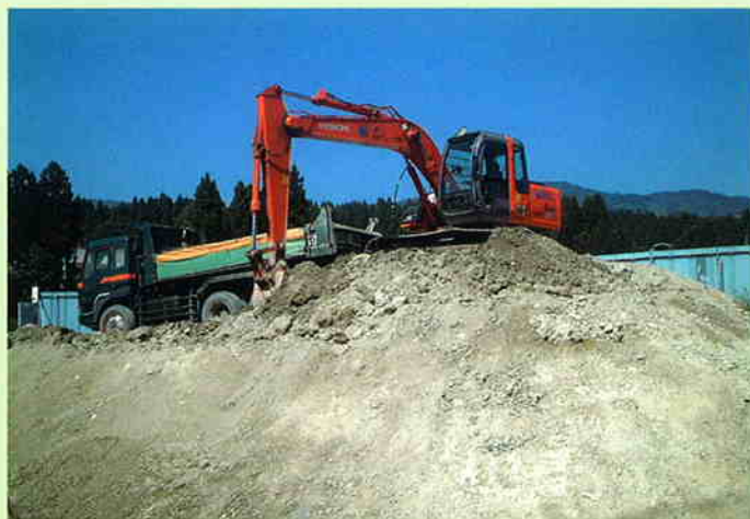
固化処理土は転圧5日目でコーン指数800kN/m 2 以上。
