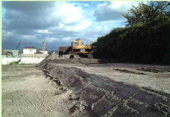
固化処理土の有効活用/路床、路盤改良材。
