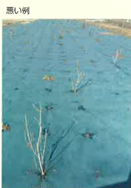
防草ワッシャー®不使用 止めピンの穴から雑草が生えている
