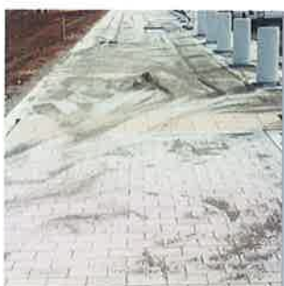
インターロッキング
