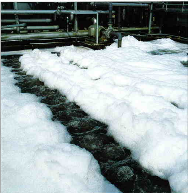
・消泡手段を施していない曝気槽
