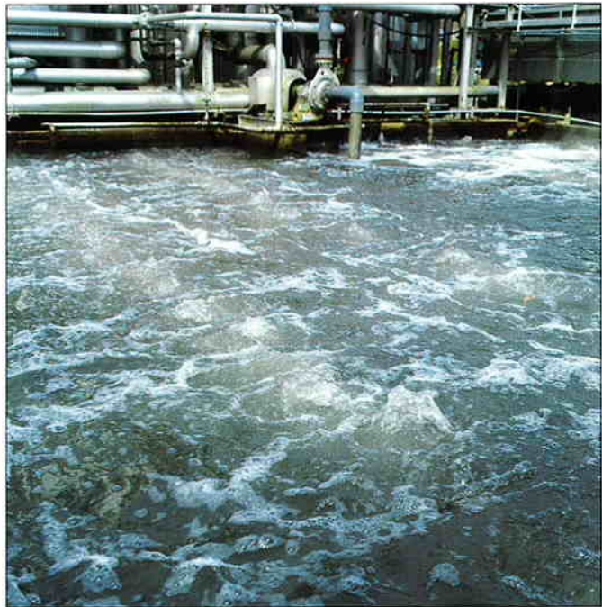
・消泡剤クリレス使用中の曝気槽
