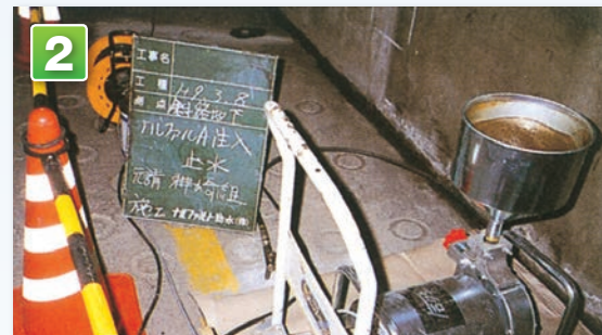
注入液を圧入
