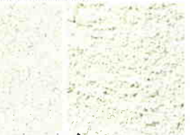
吹付け仕上げ
