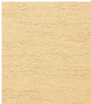
吹付け 荒壁仕上げ (257) 吹付け + コテ (下吹き)リシンガン (上吹き)タイルガン+機 PCH PCDH
