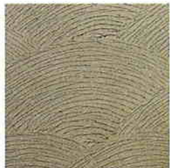
パイプローラー 扇仕上げ (137)
