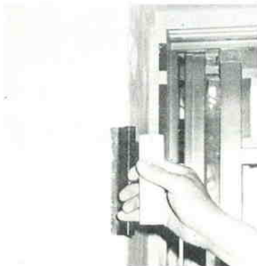
② 定木の取付け
