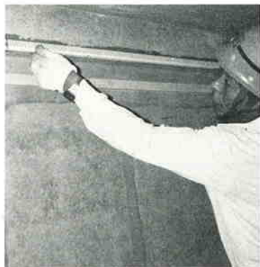
② 定木の取付け
