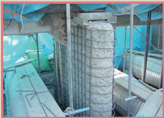
海岸地域のコンクリート・劣化躯体の補修
