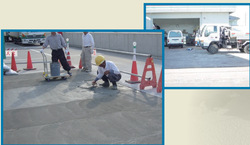
ガソリンスタンド・駐車場の補修
