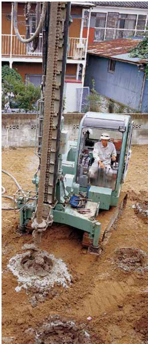
ソイルセメントコラム工法
