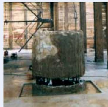
杭頭をショベルやクレーン等の重機で吊上げたり、分割して撤去します。
