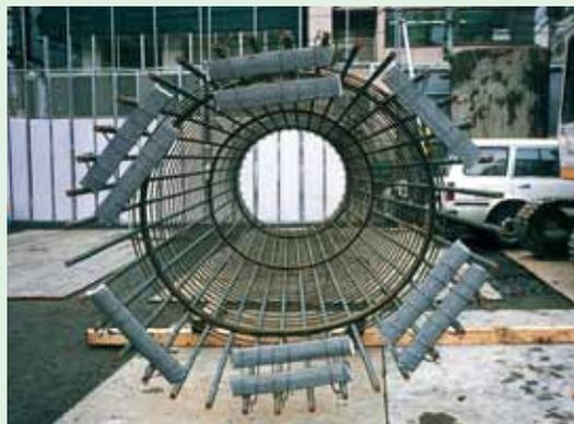
**3** 縁切材をすべての主筋に挿入し、固定します。取付け金具は縁切材の中へ入れ、縁切材と一緒に主筋へ固定してください。
