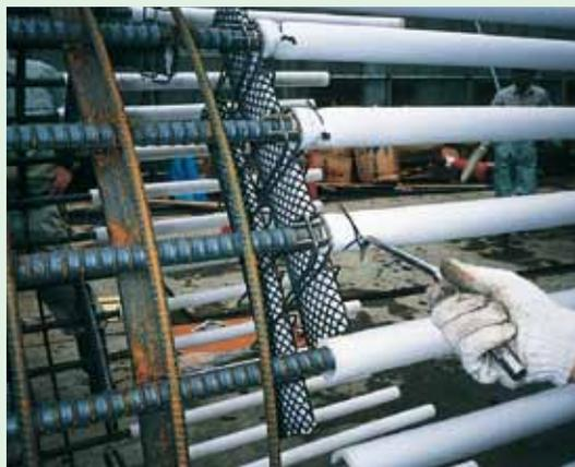
**4** 付属の取付けバンドを使用し、クイカッターを取付け金具の先端へ寄せ固定します。
