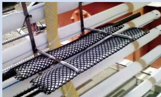
※クイカッターの取付け精度はクラックの精度に大きく影響します。取付け手順書(別紙)に従って、正確に設置してください。不明点がございましたら、弊社までお問い合わせください。
