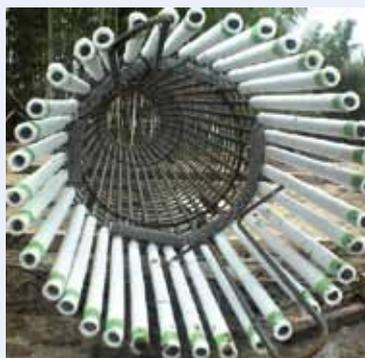
鉄筋籠にクイカッターを取付けます。取付け後に建込み、コンクリート打設を行います。
