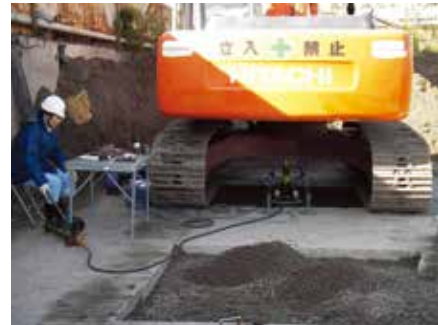
写真-3 平板載荷試験状況 (反力として20tf級バックホウを使用)
