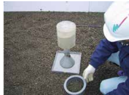
写真-1 現場密度試験状況
