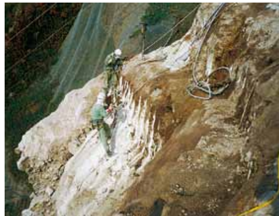
急傾斜地の破碎
