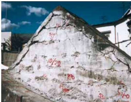
基礎コンクリートの破碎
