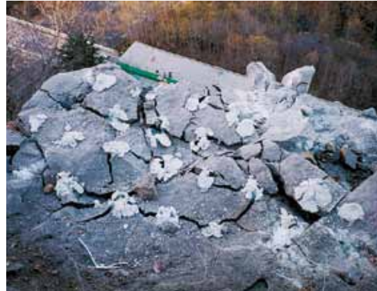
急傾斜岩盤の破碎
