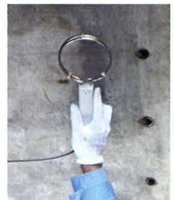
● 現場での計測状況
