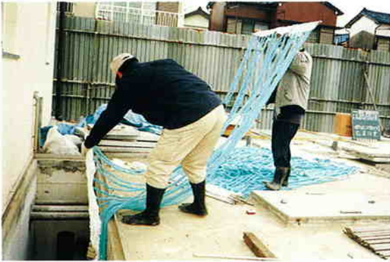
農業集落排水処理施設 施工中
