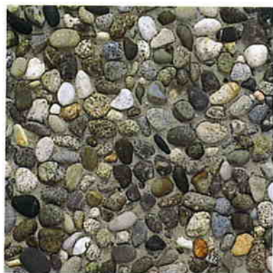
見本：洗い出し工法仕上げ
