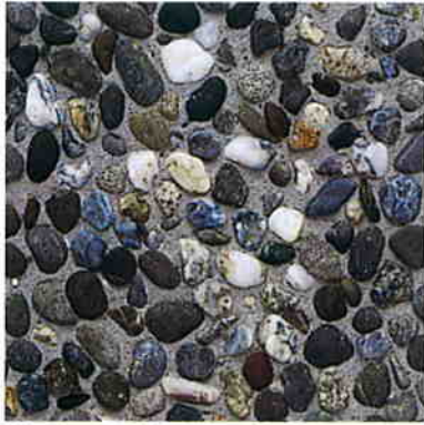
見本：洗い出し工法仕上げ
