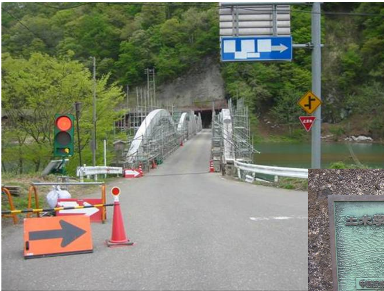
RF厚付モルタルKTによる断面修復処理(一般国道)
